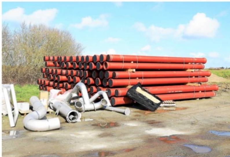
À la station de Saint-Déneç, à Porspoder, des tuyaux sont prêts pour la fin du raccordement à l'anse de Saint-Gildas, à Lanildut.
